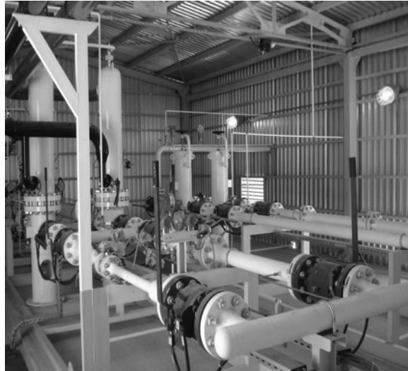
Şekil 1. Rms - A İstasyonu
