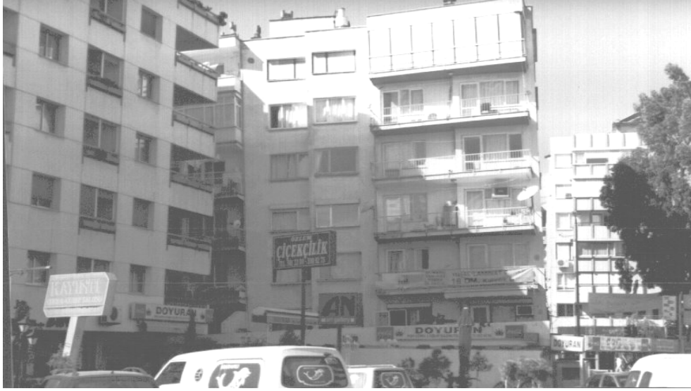
Şekil 2. Bostanlı’ da rijit dönme ve farklı oturma yapan binalar
