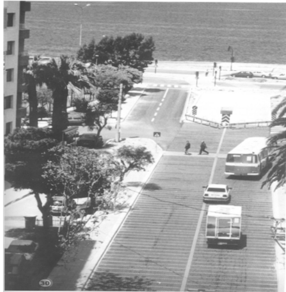
Dere yatağına yol ve bina yapılmışsa, dere yatağı binalardan dolayı genişletilemiyorsa, kamulaştırma yapılamıyorsa, yola da ihtiyaç varsa ve başka yerden de geçiremiyorsak, çelik yol yaparız. Böylece büyük bir sel gelirse, su insanlara ve binalara zarar vermeden, çelik yoldan taşarak denize doğru akıp gider.
