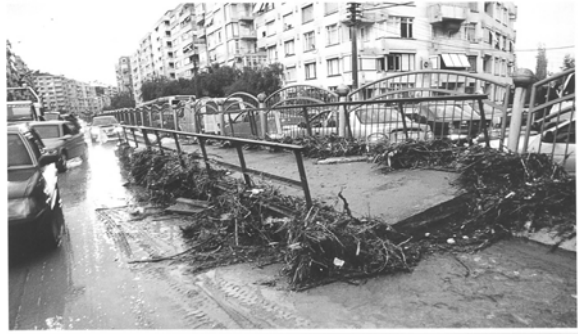
Yanlış uygulamaların sonucu: Poligon Deresi taşmış, yaya köprüsü caddenin ortasında...
