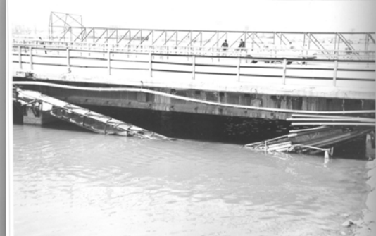
Dere yatağındaki kablolar kaldırılıyor.
