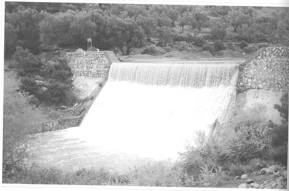
Daha önce yapılmış bir bent tamir edilerek duvarları yükseltildi.
