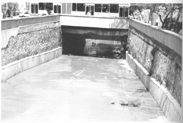
Dere yatağı üzerinde, yatağı daraltan veya orta ayağı olduğu için selle beraber gelen ağaç, dal, yatak, yorgan, araba lastiğinin takılmasıyla yatağı tıkayan yaya köprüleri varsa, bunları yıkıp ayağı olmayan, suyu üstünden ve altından rahatlıkla geçirebilen, basit, ucuz, hoş ve renkli yaya köprüleri yaparız.
