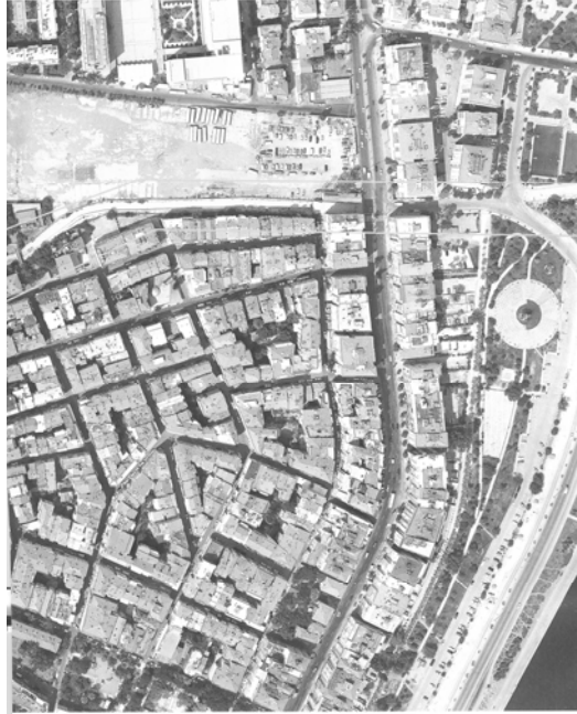
Yanlış imar kararlarının ve uygulamalarının boğduğu Poligon Deresi: İnönü Caddesi ile Sahil Yolu arasında dere yatağının daraldığı, binalarla işgal edildiği, Mithatpaşa Caddesi ve Sahil Yolu rın altında kaybolduğu açıkça görülmektedir. Bu da yetememi gibi otoyulun bütün suları toplandı buraya geliyor. Ama otoyulun bozduğu havada ise erozyon enerjisi tedbirleri alınmaz. Önce apartmanı yıkmak, köprüleri, geçitleri yıkıp yeniden yapmak gerekiyor.
