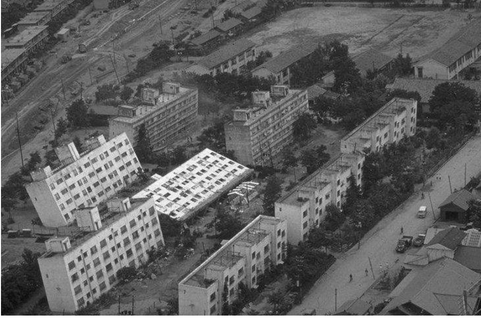
Şekil 4 Sıvılaşma - Niigata Japonya Depremi (1964), Kawagishi-cho Apartmanları
