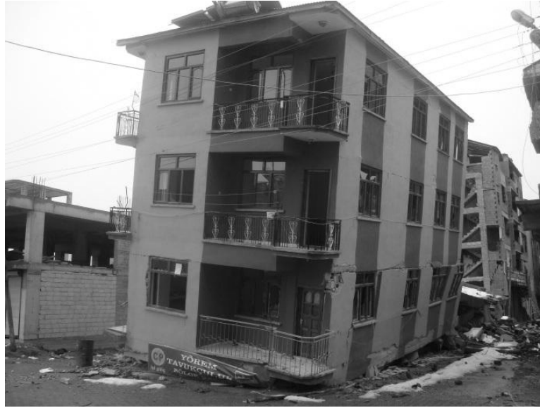
Şekil 8 Yumuşak kat / Zayıf kat
