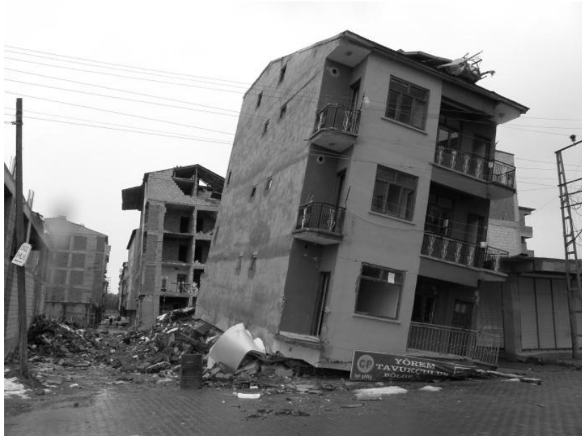
Şekil 9 Van Erciş'te yumuşak kat sebebiyle zemin kat kolonları göçmüş ağır hasarlı yapı.
