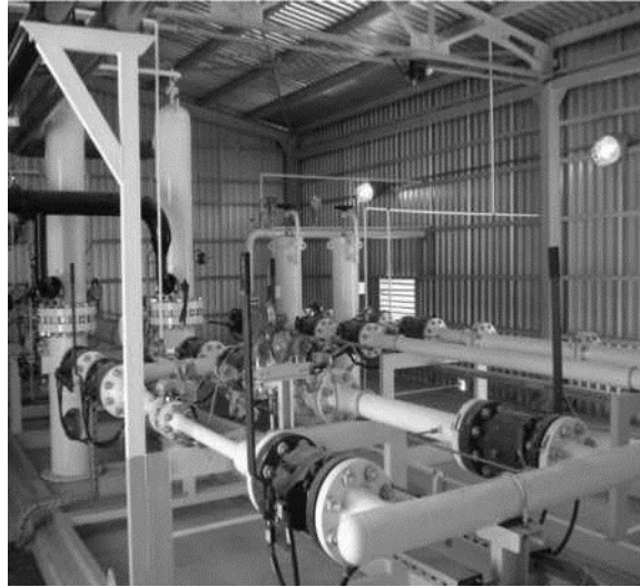
Şekil 1. Rms - A İstasyonu
