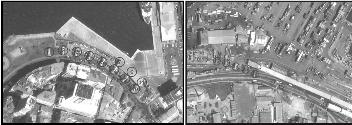
Şekil 1 Kordon Köprüyol Ayakları
