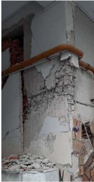
Şekil-14. Kolon ve perdelerde gelişen hasarlar
