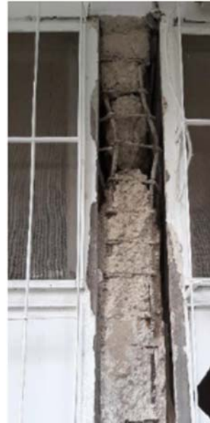
Şekil-14. Kolon ve perdelerde gelişen hasarlar
