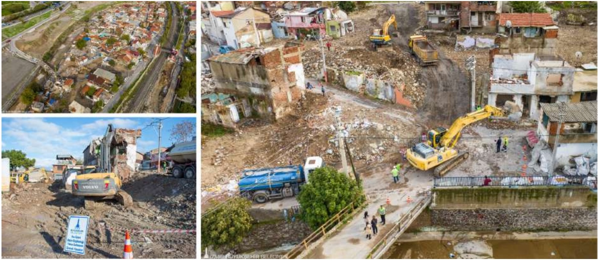
Şekil 3. Yeşildere Bölgesindeki Yıkım Çalışmalarına İlişkin Görüntüler (Kaynak: İzmir Büyükşehir Belediyesi Web Sitesi)
